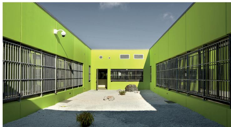
Grâce à la technique du double mur (deux parois de béton entre lesquelles s'insère une couche d'isolant) et de son motif à dominante verticale, la peau extérieure se décline, face aux ouvrants, en claustras faisant office de barreaudage de sécurité et de brise-soleil. Les branchages qui ainsi se dessinent, en évitant de renvoyer aux occupants de l'UHSA une stricte image carcérale de leur lieu de vie, réussissent à transcender la problématique notion d'enfermement... ■
