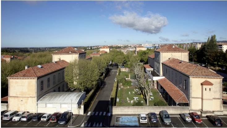
Aix-en-Provence, asile de Montperrin, les pavillons alignés.
